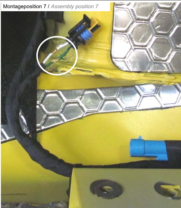
Isolierung des Kabels entfernen.
